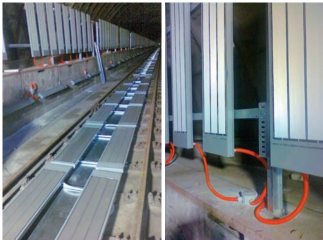
Nainštalované infražiaríče v rozmrazovacom tuneli
