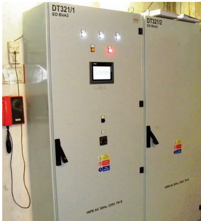
Rozvádzač s riadiacim systémom SIMATIC S7-300
