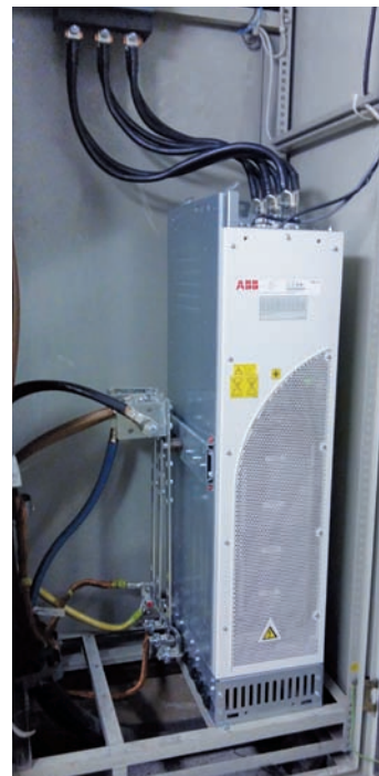
Frekvenčný menič ABB ACS 604 s výkonom 200 kW na riadenie otáčok bagrovacieho čerpadla
