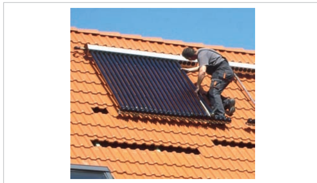
Obr. 7 Porušenie bezpečnostných predpisov pri montáži – práca na streche bez pripútania
