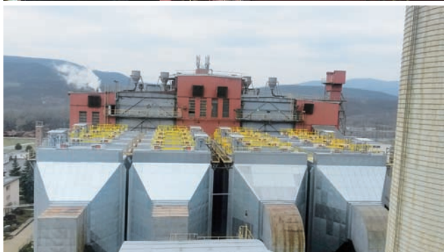
Elektrostatické odlučovače blokov č. 1 a 2 ENO B
